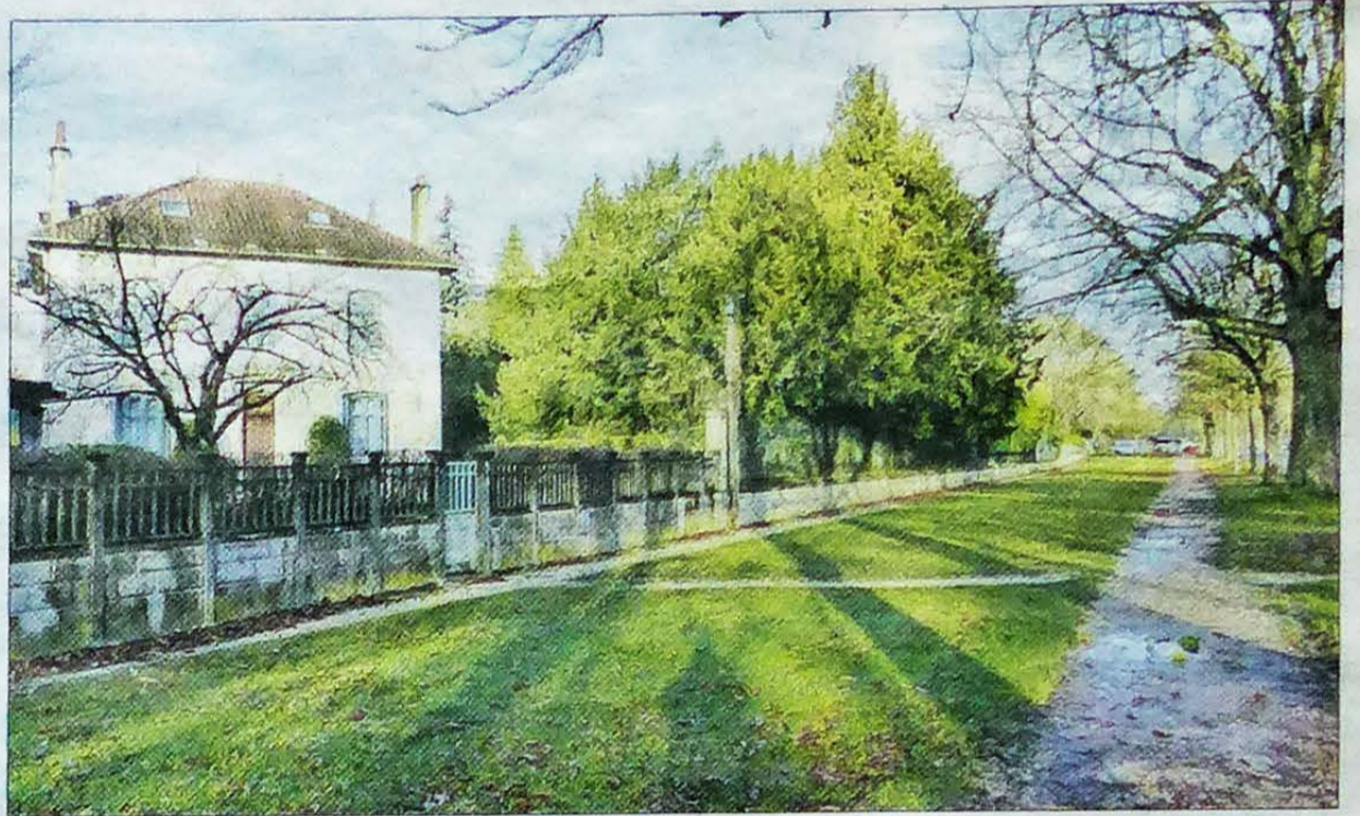
Le programme de Cofipari devait se construire à l'angle de la rue Ernest-Bailly et du cours du Parc, à Dijon. Photo DR
